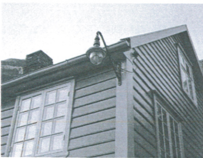
Gatebelysning i verneområdet er planlagt av Arbeidsutvalget og godkjent av Riksantikvaren FOTO: CLAUDS LINDSTRØM
