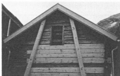
Utbedringsarbeid på tømret sjøhus FOTO: CLAUS LINDSTRØM
