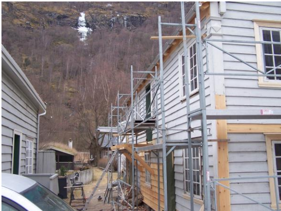
Restaurering av bygg 2009
