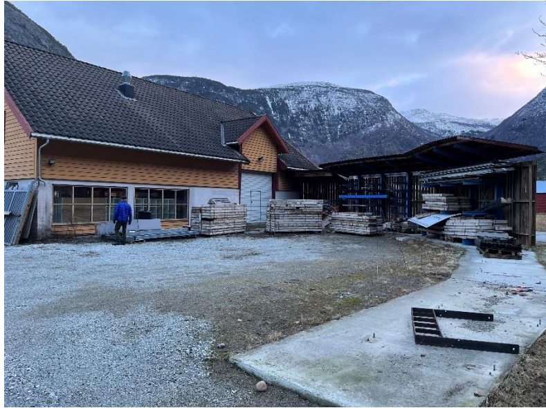
Bilde 18 Baksiden av Fretland bygg.
